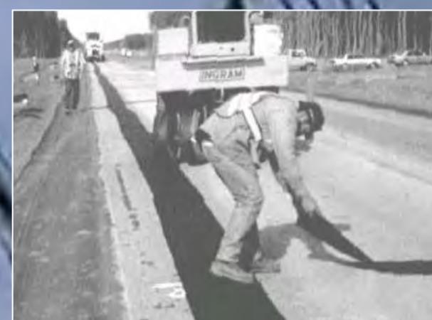
Carretera amb paviment d'asfalt
